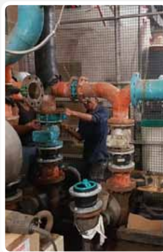
老舊閥件拆除，泵浦閥件換新，避免管路破裂漏水
