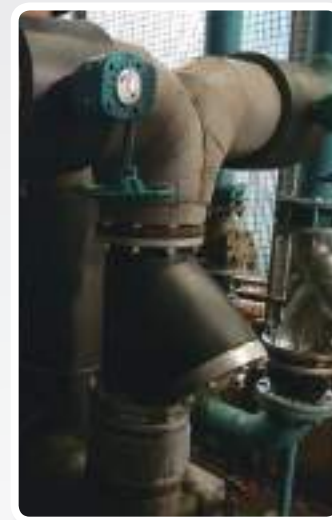
老旧阀件拆除, 泵浦阀件换新, 避免管路破裂漏水
