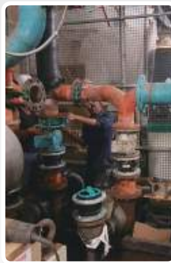
老旧阀件拆除, 泵浦阀件换新, 避免管路破裂漏水
